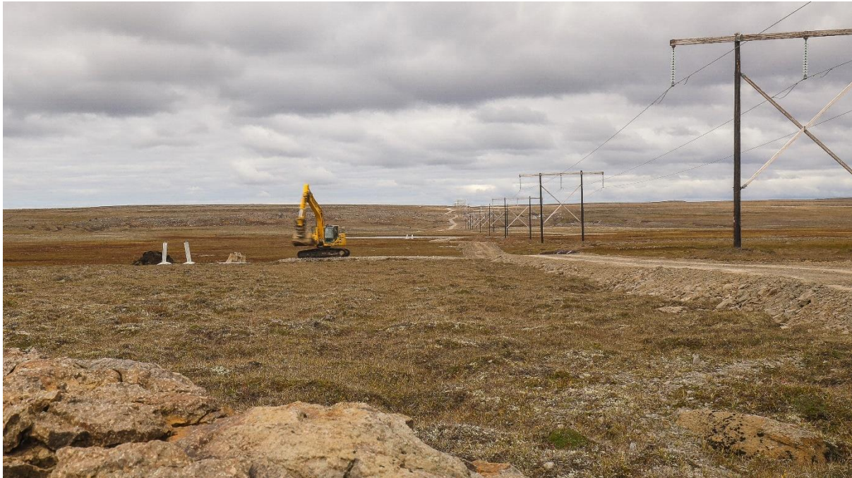
Mynd 5.5. Slóðagerð við Kröflulínu 3. Á myndinni sést núverandi 132 kV loftlína þar sem lögð hefur verið slóð samsíða og undirbúin mastraplön fyrir nýja 220 kV Kröflulínu 3.
