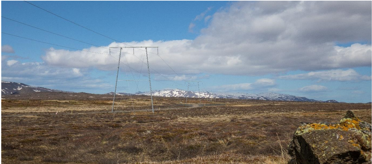
Mynd 5.2 Mastursgerð sem fyrirhugað er að nota á stærstum hluta Holtavörðuheiðarlínu 3. Mynd sýnir mastur án jarðvírseyrna.
