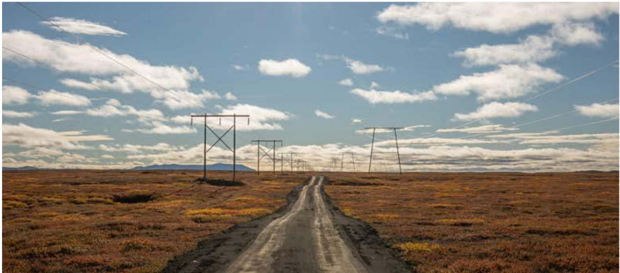
Mynd 5.3 Kröflulína 3, dæmi um 220 kV línu (hægri) meðfram eldri 132 kV línu (vinstri).
