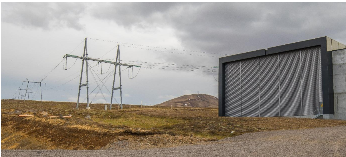
Mynd 5.4 Dæmi um endamastur, með jarðvírseyrum hjá tengivirki.
